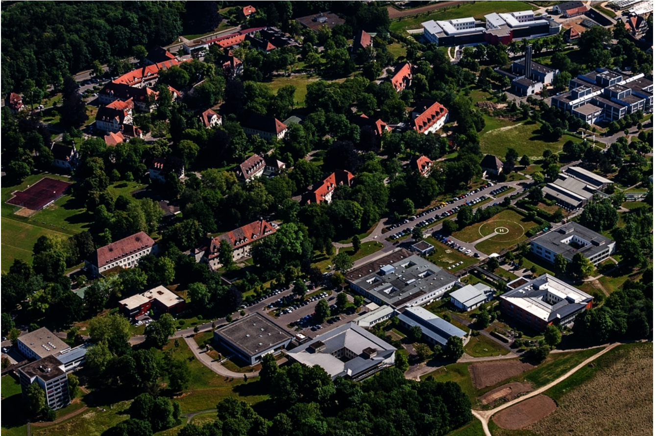
Abbildung: Luftaufnahme Bezirkskrankenhaus Günzburg
