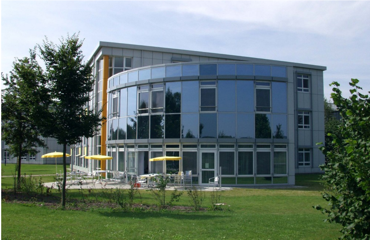
Abbildung Bezirkskrankenhaus Donauwörth, Außenansicht
