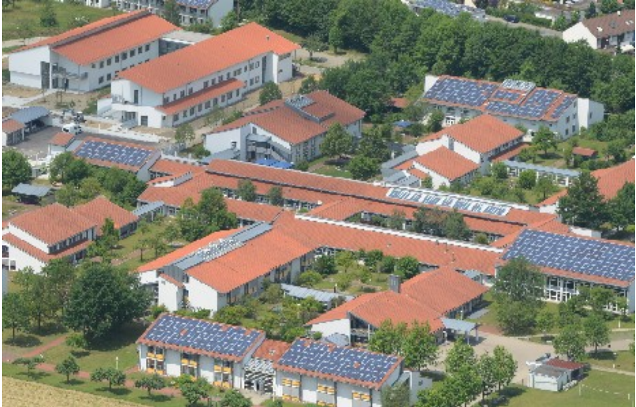
Bezirkskrankenhaus Augsburg Luftaufnahme 2017
