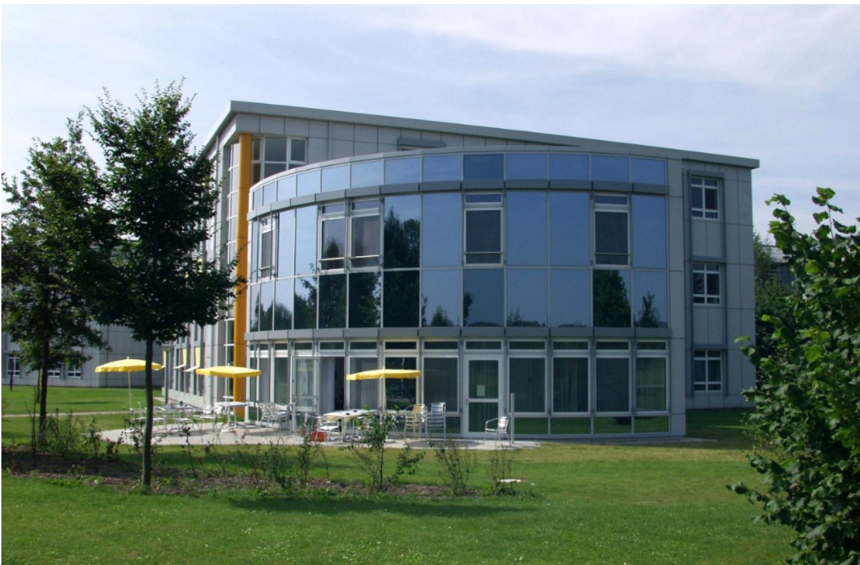
Außenansicht Bezirkskrankenhaus Donauwörth
