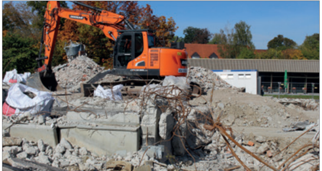
Rechts hinten blitzt bereits der Neubau der Speiserversorgung (Haus 7) hervor.
