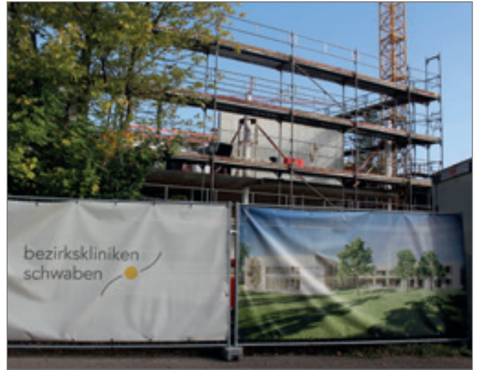
Die Animation am Bauzaun zeigt, was dahinter einmal entstehen soll.
